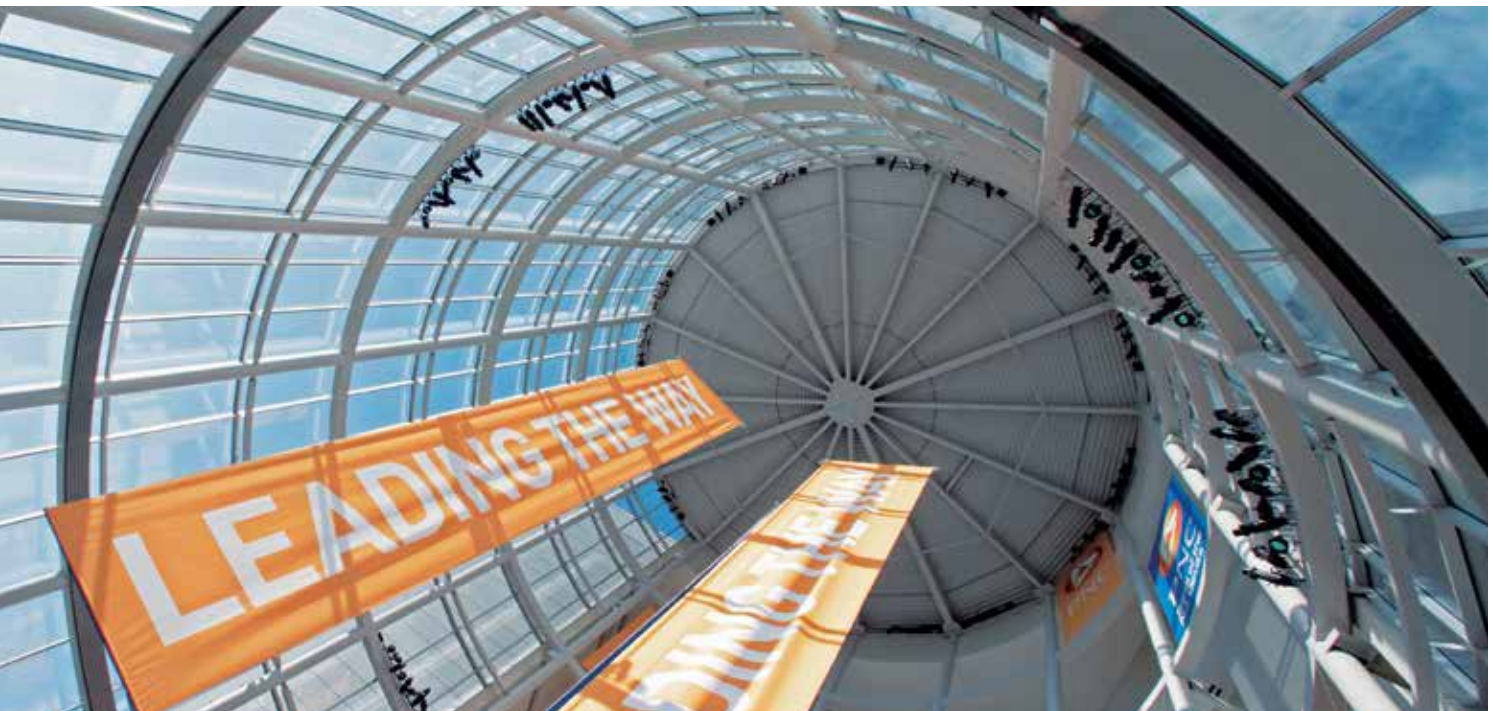
PRUDENTIAL CENTER | Lieu : Newark, New Jersey | Produit : Verre Solarban MD 60/ Starphire MD | Architecte : Morris Adjmi Architects, HOK Sport+Venue+Event Fabricant du verre : JE Berkowitz, LP | Entrepreneur chargé des vitrages : Josloff Glass | Photo de Tom Kessler
