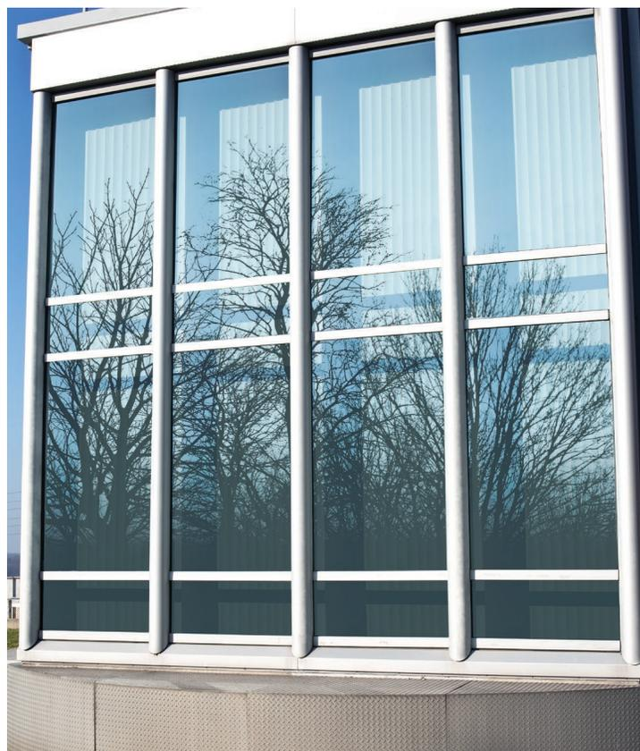
El vidrio Solarban® R77, con su reflectancia exterior del 25 por ciento, es ideal para realizar diseños de fachadas y muros cortina destinados a capturar el carácter visual del cielo y el entorno ambiental.
